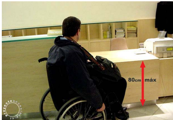
Foto 22: Altura máx. de mesón de recepción.
