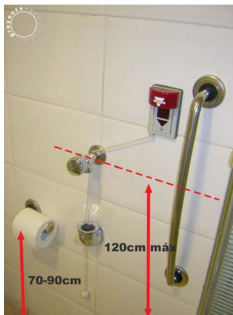
Foto 21: Altura máx. y mín. de accesorios en baño.
