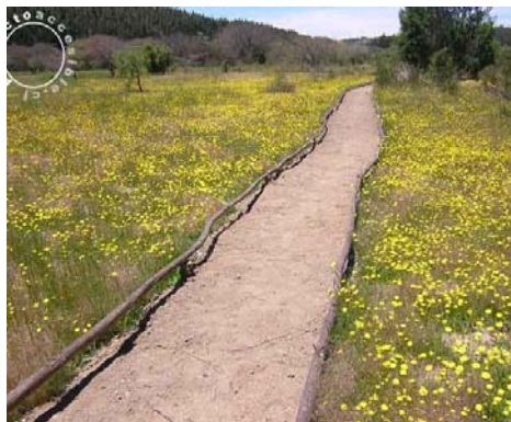
Foto 4: Barra guía para ciegos en sendero accesible.
