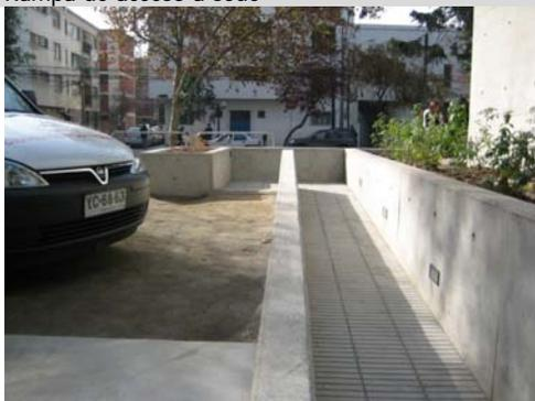
La rampa mide 90 cm de ancho, presenta un giro de 90° de 1 mt de profundidad. El espacio de giro es insuficiente, se logra pero con dificultad. El segundo tramo de rampa mide 10 mt, de pendiente aceptable pero sin el descanso normado cada 9 mts. El descanso es importante cuando se maneja la silla de ruedas en forma autónoma.
