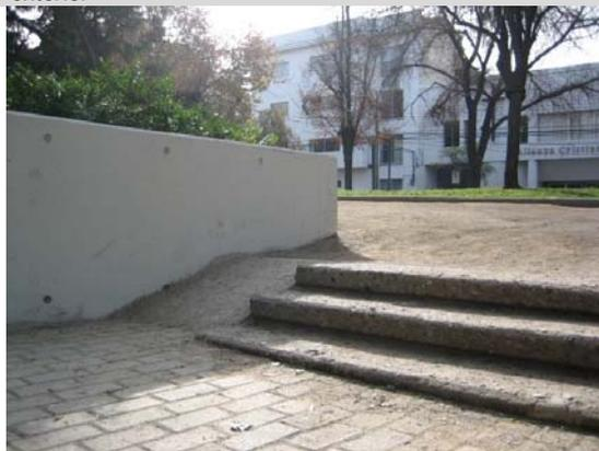
La solución para acceder a este sector muestra una rampa añadida con posterioridad para salvar el desnivel existente por tres peldaños. Se achafanó un extremo resultando una "rampa" de 37% de pendiente y de 70 cm de ancho. Medidas totalmente insuficientes si se considera que el ancho mínimo de desplazamiento es de 80 cm y el porcentaje mínimo aceptable para una rampa de hasta 2 mt de longitud no debe superar el 12% de pendiente (Fuente: OGUC).
