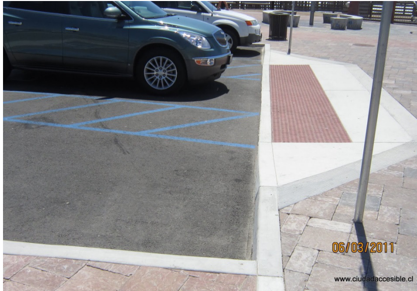
Acceso a vereda en estacionamiento reservado para personas con discapacidad.
