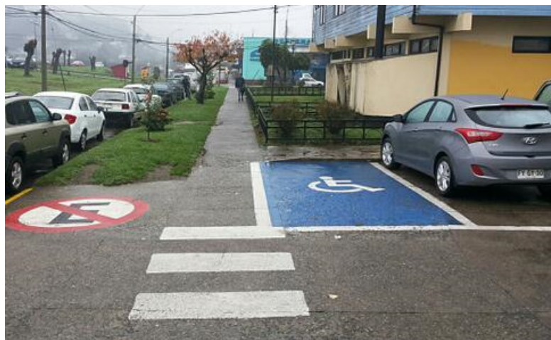
Estacionamiento en vía pública instalados de tal forma que permite un acceso y circulación segura (Los Lagos)
