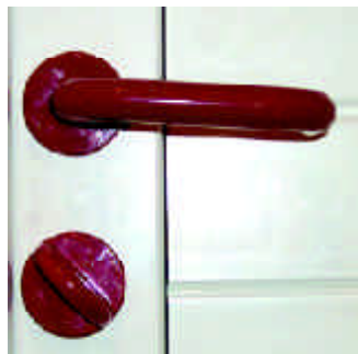
Puerta de Baño con pestillo de seguridad. De fácil agarre y contraste de color adecuado.
