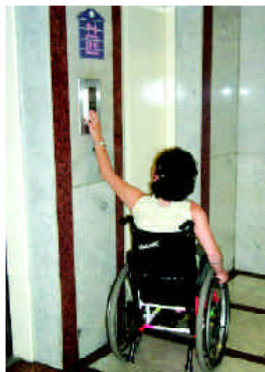
Altura incorrecta de la botonera exterior. Ascensor Parque Arauco
