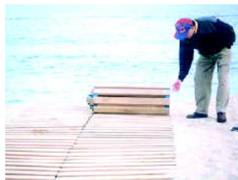
Pasarela enrollable de madera para la circulación de sillas de ruedas sobre arena. [www.rovira-beleta.com](http://www.rovira-beleta.com)
