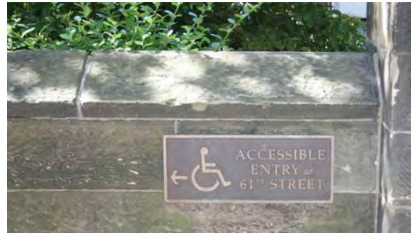
Información gráfica que indica en la entrada principal el acceso alternativo en una edificación antigua e inaccesible.
