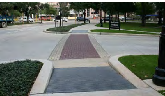
Cruce en vereda angosta. La vereda baja en todo su ancho hasta alcanzar la cota de la calzada. Una franja de textura diferente hace perceptible el cruce y el cambio de color ayuda a demarcar la zona peatonal.
