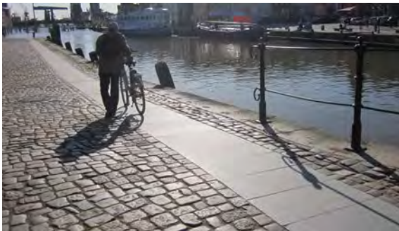
Ruta accesible en zona de valor patrimonial. Se modifica el pavimento en la ruta para facilitar el desplazamiento debido a las complicaciones que presenta el adoquín.
