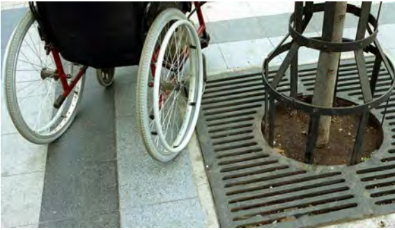
Una protección adecuada a las tazas de árboles que invaden el trayecto peatonal evita accidentes en los peatones.
