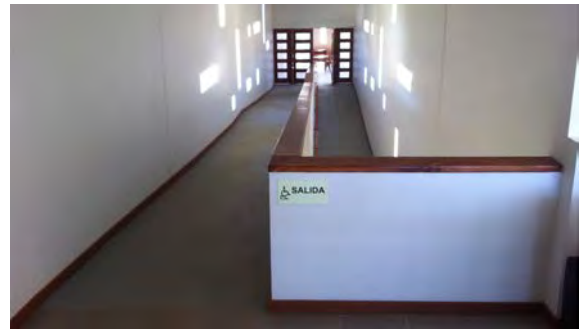
Rampas interiores son excelente alternativa para salvar desniveles especialmente en lugares de alto desplazamiento simultáneo de personas y para las evacuaciones en caso de emergencia.
