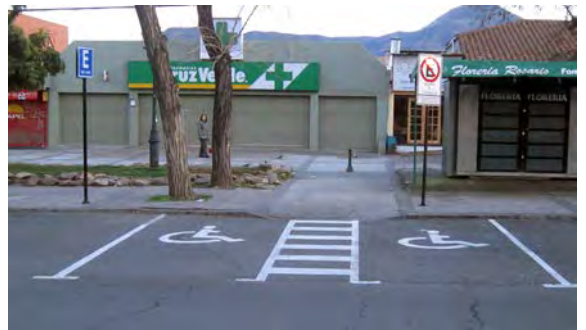
Estacionamiento en la vía pública. Dimensiones correctas y acceso a nivel con la vereda.
