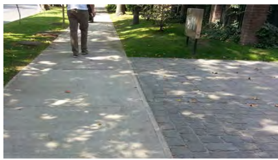
Vereda de pavimento estable y liso. El cambio de material usado en el acceso al edificio no interrumpe la vereda.
