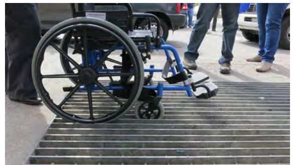
Las rejillas en las circulaciones peatonales deben ser instaladas perpendicular a la circulación y su ancho no debe permitir el atascue de una rueda.
