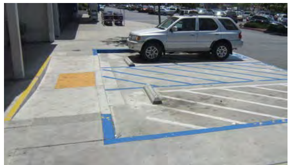
Estacionamiento para personas con discapacidad con acceso seguro hasta la vereda..
