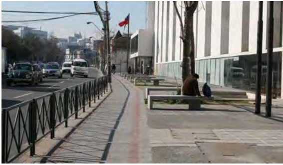
Vereda con franja de circulación despejada. Facilita a todos los peatones un desplazamiento más seguro y cómodo.
