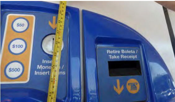
Las cajas de pago automáticas de estacionamientos deben contemplar una altura máxima de 120 cm para insertar monedas o retirar tickets.
