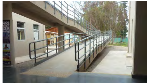
Una rampa de buen diseño es una excelente solución de circulación a un edificio de uso público y ahorra costos posteriores de mantención de ascensores.
