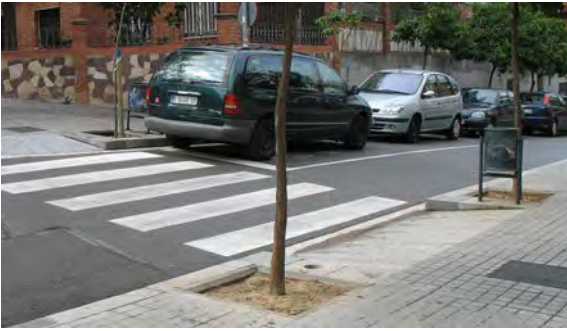
Rebaje de vereda en todo el ancho del cruce peatonal, de buena pendiente y protecciones laterales.
