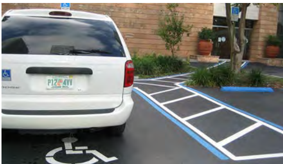
Estacionamiento con franja de circulación hasta el acceso. Esto otorga seguridad en el desplazamiento a personas con movilidad reducida.
