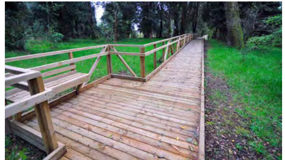
Pasarelas accesibles en parque urbano. Permiten visitar un área silvestre en cualquier condición de movilidad. Las áreas de descanso se ubican fuera del itinerario.
