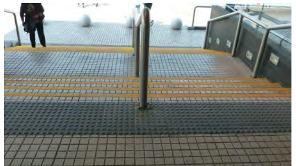
Textura de advertencia en el piso informa a personas con discapacidad visual un riesgo en el recorrido e inicio de escalera.
