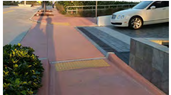
Una franja de advertencia en la vereda indica la proximidad de una salida de vehículos.
