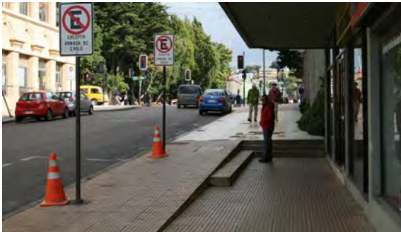
Las veredas deben resolver los desniveles con rampas de suave pendiente que favorezcan a todos un desplazamiento sin interrupciones.
