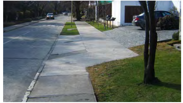
Acceso vehicular a domicilio que no interrumpe ni modifica la materialidad ni la pendiente de la vereda manteniendo las condiciones de ruta accesible.
