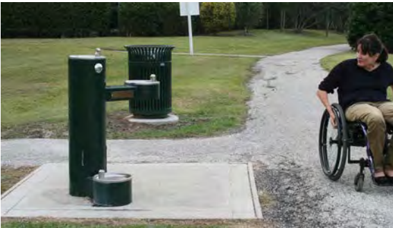
Fuente de agua que se adapta a todas las alturas de uso (de pie, sentado y para animales). No estorba el recorrido pero mantiene acceso a nivel con éste.
