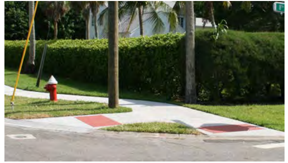
Cruce peatonal en vereda angosta. La vereda baja en todo su ancho hasta alcanzar la cota de la calzada. Una franja de textura hace perceptible el cruce.
