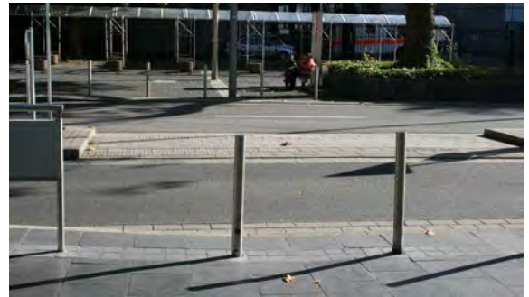
Bolardos distanciados que permiten la circulación peatonal inclusive en silla de ruedas e impiden el acceso de vehículos.
