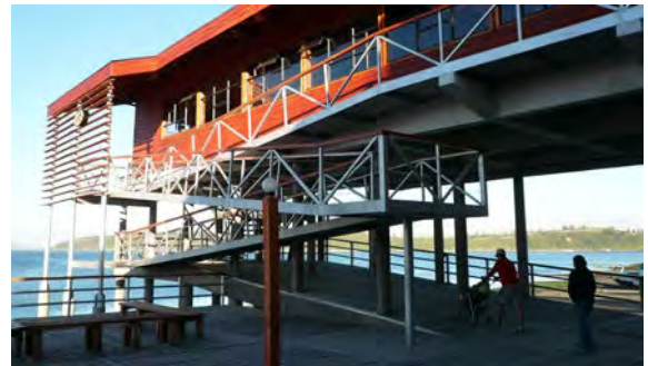
Acceso universal a la edificación. Rampas de suave pendiente son una excelente alternativa para todos.
