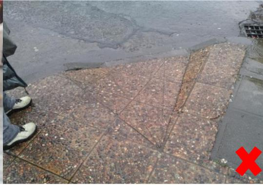
Rebaje solera Peatonal mal diseñado, impide su función
