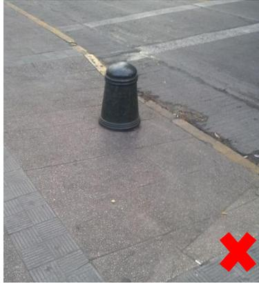
Bolardo en medio de un Rebaje de Solera Peatonal impide el funcionamiento del rebaje.
