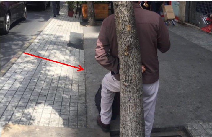
Pendiente transversal actual en calle San Antonio
