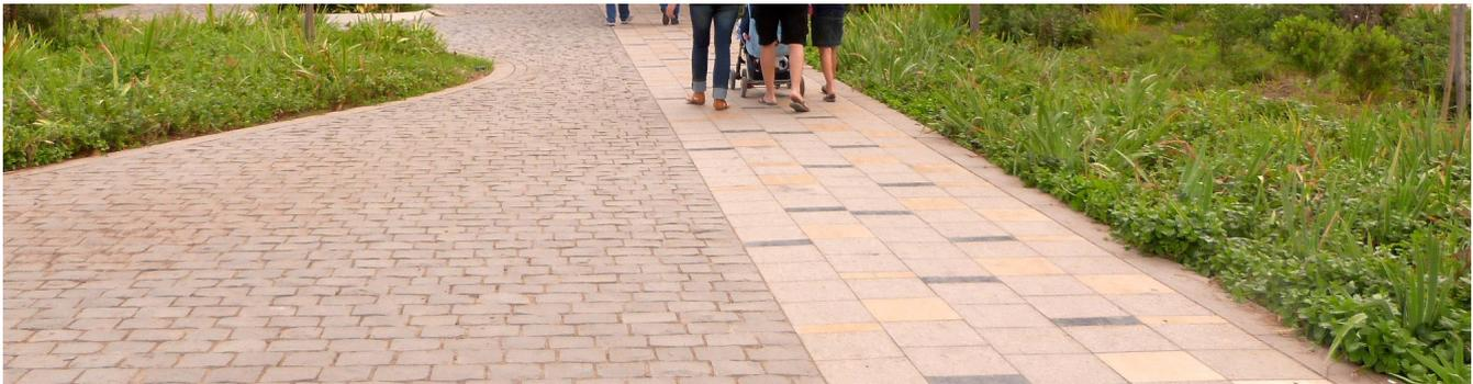
*El pavimento liso entre adoquines irregulares otorga las condiciones de accesibilidad universal al recorrido.*
