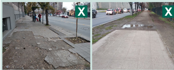
Las circulaciones, tanto del interior como del exterior del recinto requieren material firme, estable y sin desniveles.
