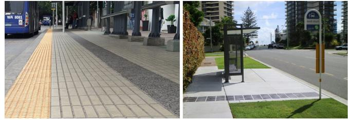
Foto izq.: Pavimento de alerta advierte el desnivel con la calzada. Foto der.: Pavimento guía direcciona desde la línea de edificación hacia el paradero.
