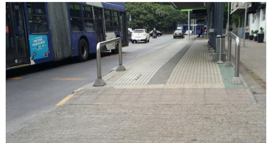
La imagen y fotografía muestran un paradero conectado a la vereda mediante una rampa de suave pendiente. La altura del área de espera permite disminuir la diferencia de altura del bus con el andén, minimizando la pendiente de la rampa de acceso a éste.
