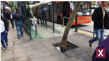
Paradero sobre el nivel de la vereda. El acceso con rampa debe ser por ambos extremos.
