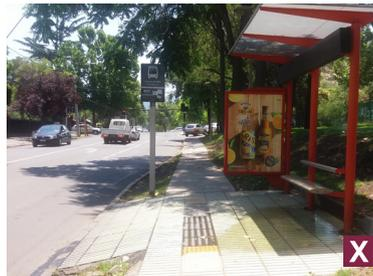
El área de abordaje o descenso del bus no debe tener pendientes superiores al 2% en ninguna dirección. Desde una silla de ruedas implica frenar constantemente las ruedas para no caer hacia la calzada.
