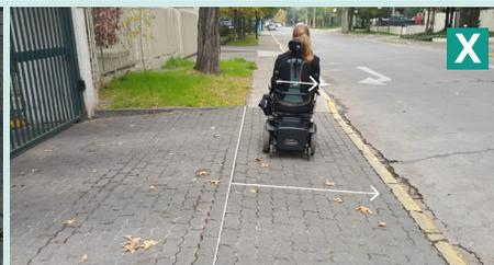
**X** Foto izq: La vereda debe mantener un ancho mínimo de 1,2 m o en casos puntuales de 0,9 m, sin alterar la pendiente transversal de máx. 2%.
