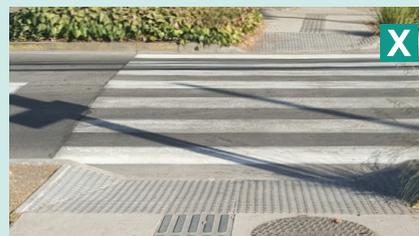
Fotos izq. y centro: El pavimento táctil de alerta antecede la rampa del rebaje en un ancho mínimo de 0,4 m, condición primordial para alertar a las personas ciegas de la proximidad del cruce. Foto der: El pavimento táctil de alerta cubre totalmente la rampa lo que dificulta el paso a sillas de rueda.
