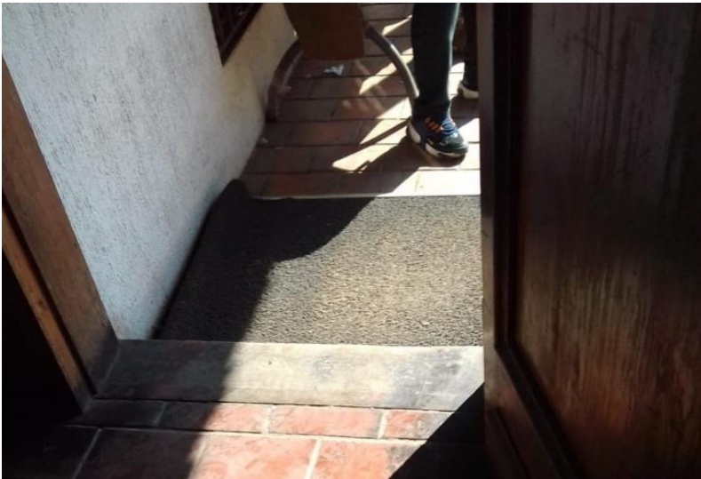
Peldaño en puerta de acceso
